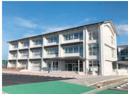
佐賀北高校通信制校舎内に設置
